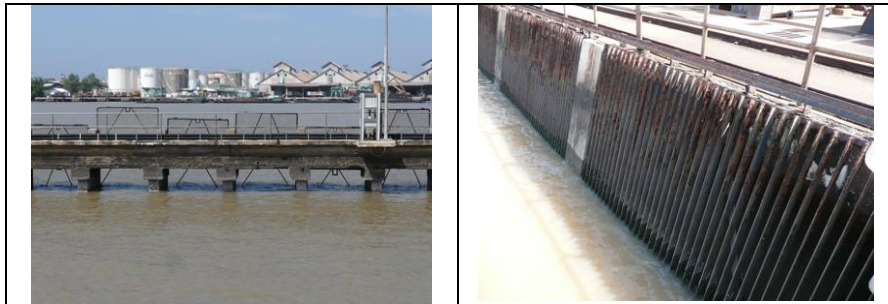
รูปที่ ค-19 ตะแกรงขนาดต่างๆ ที่ติดตั้งบริเวณ Intake
