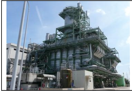
รูปที่ ค-24 ติดตั้งระบบฉนวนป้องกันความร้อน (Insulation) บริเวณแหล่งกำเนิดความร้อน
